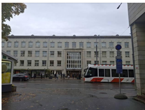
Foto 42. Lisaks vaadetele Terra hoonele mõlemast suunast on oluline vaade Vase tänava otsast Terra peaukse suunas – sinna on planeeritud mugav kergliikluse teeületus.
